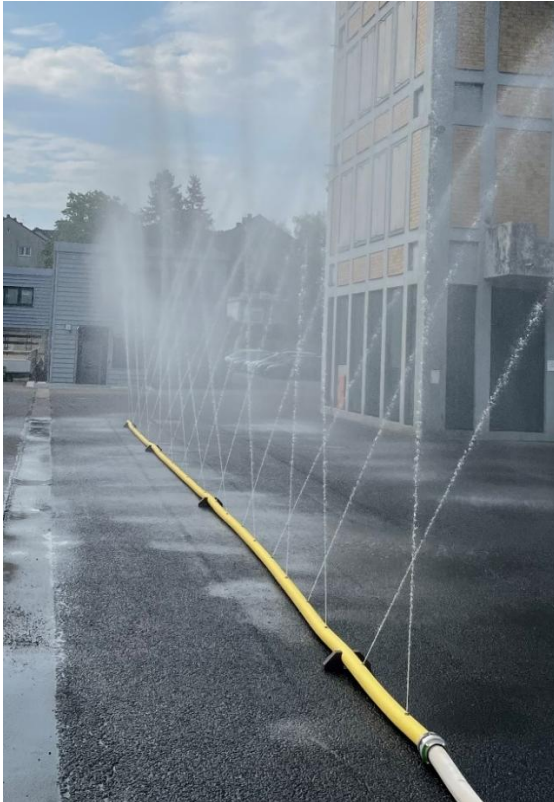
Abb. 7.10: Düsenschlauch im Einsatz [A.Seiffen, BF Offenbach]
